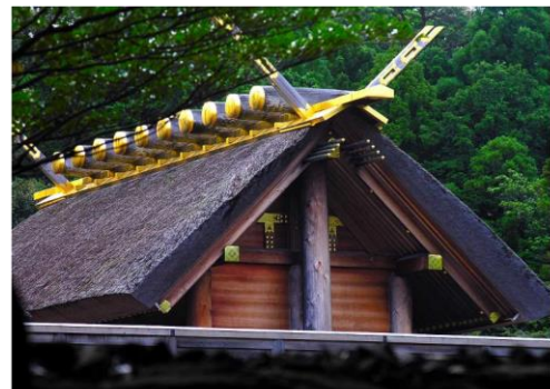
伊勢神宮内宮（内削ぎ。横） アマテラス（天照大神）女神 内削ぎ（女の神様を祭っている）
